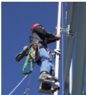
10. ábra: Felmászás egy NOK rácsszerkezetű oszlopra a „HighStep” rendszer és egy emberi erővel működtetett „fellépő” segítségével
