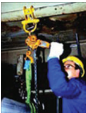
2. ábra: Hogyan erősítsünk csöveket a mennyezethez úgy, hogy megelőzzük azok leesését
